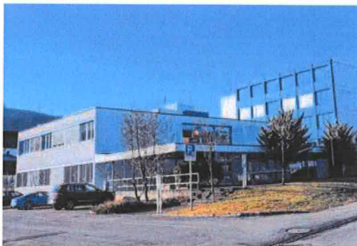
Das neue Rathaus (rechts) und Justizgebäude Leutschen entstehen hier. Während das Rathaus bereits saniert ist und weiterverwendet werden kann, wird das Justizgebäude abgebrochen und neu erstellt.
