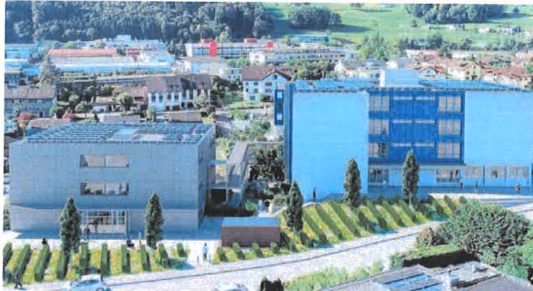
So soll das neue Rathaus mit neuem Justizgebäude (links) in Freienbach dereinst aussehen.
