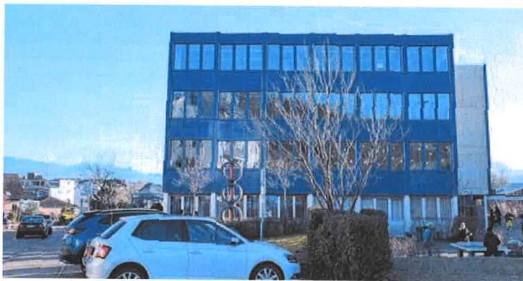
Der zukünftige Standort des Bezirks Höfe wird von der Rebhaldenstrasse aus erschlossen. Das jetzige Schulhaus wird zum Rathaus.
