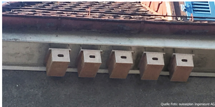
Mauersegler-Nistkästen sollen an geschützten Stellen montiert werden.
