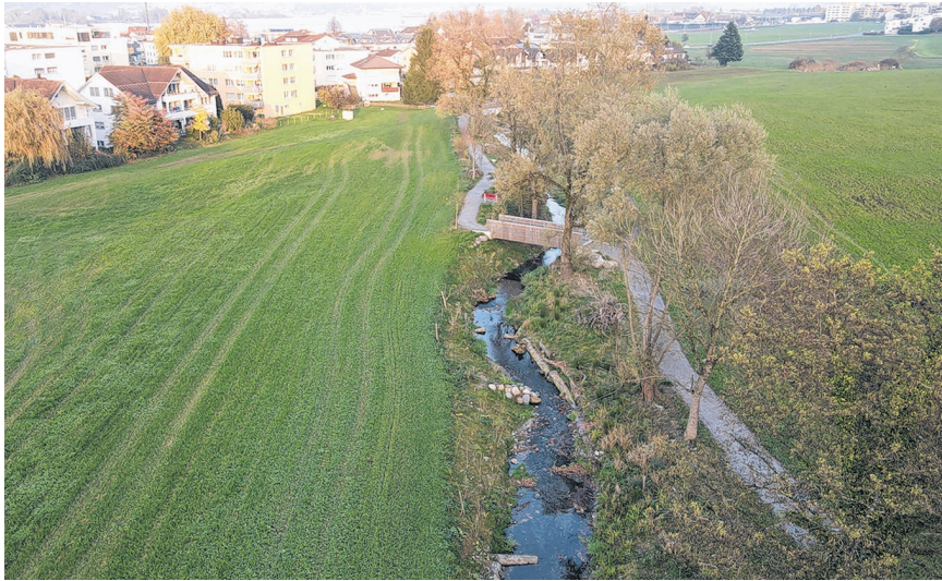
Das Hochwasser- und Revitalisierungsprojekt «Sarenbach» wurde abgeschlossen. Hier das Endergebnis in Freienbach zwischen der Langackerstrasse und Schwerzstrasse.
