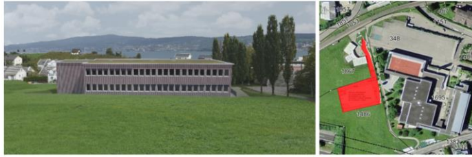
Zweigeschossiger Pavillon, behindertengerecht mit Lift
