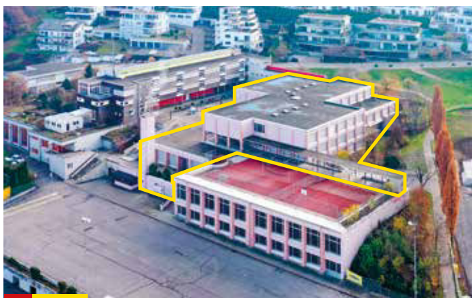
Der Westtrakt der Schulanlage Riedmatt (gelb umrandet) soll für die nächsten 40 Jahre fit gemacht werden. Der Osttrakt (links im Bild) ist nicht Bestandteil des Projekts, dürfte aber in rund zehn Jahren zur Sanierung anstehen.
