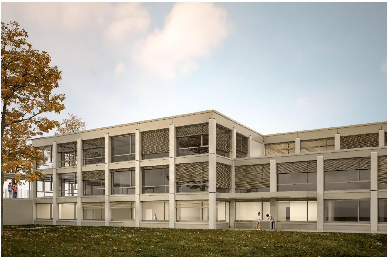
Westtrakt des Schulhauses Riedmatt: Die neue Fassade mit langlebiger, unterhaltsarmer Konstruktion bewahrt den Charakter des Schulhauses (Blick Richtung Osten).
