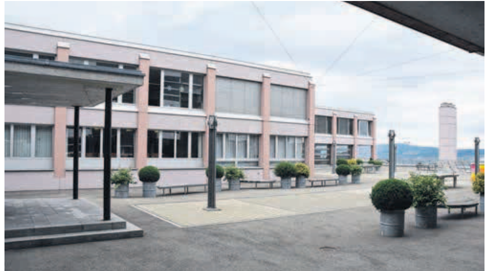
Der erste Teil der Gesamtsanierung der Schutzräume des Schulhauses Riedmatt in Wollerau ist abgeschlossen, nächste Woche folgt dann der Spatenstich für den neuen Pavillon West mit zusätzlichen Klassenzimmern. Bild Archiv
