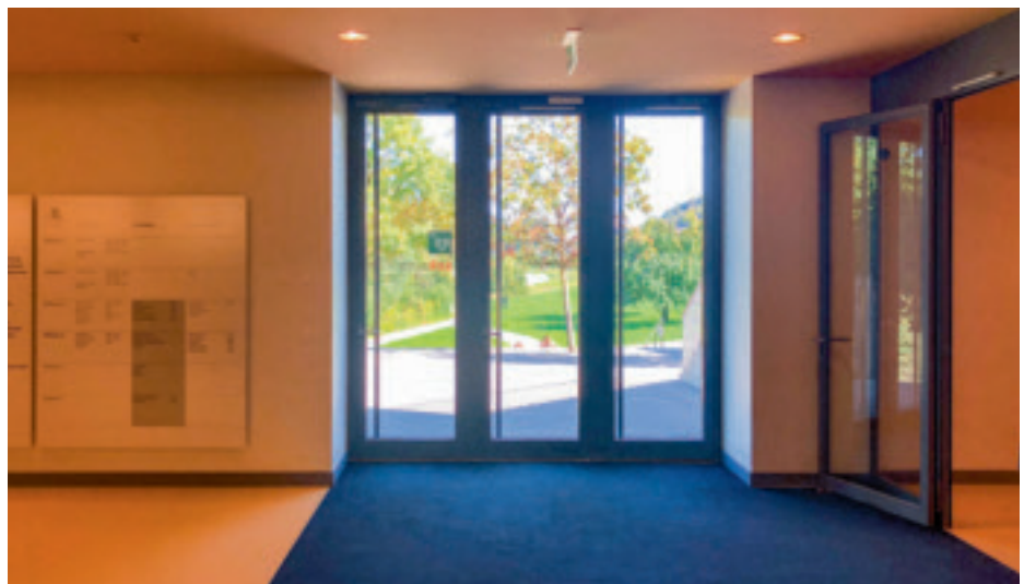
Innenansicht von der Turnhallentribüne zum Turnhallenein-/Fluchtausgang
