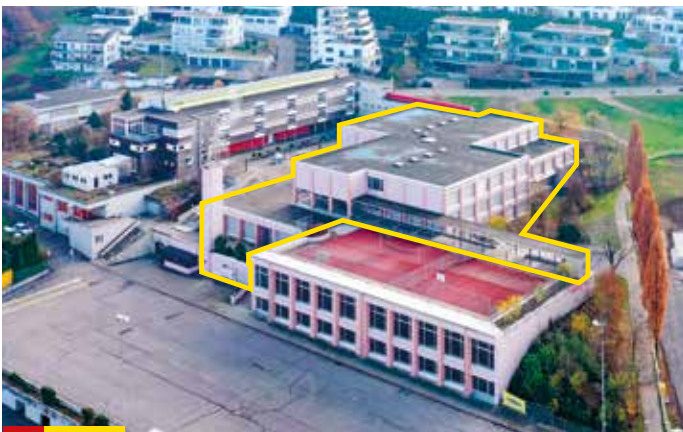
Der Westtrakt der Schulanlage Riedmatt (gelb umrandet) soll für die nächsten 40 Jahre fit gemacht werden. Der Osttrakt (links im Bild) ist nicht Bestandteil des Projekts, dürfte aber in rund zehn Jahren zur Sanierung anstehen.
