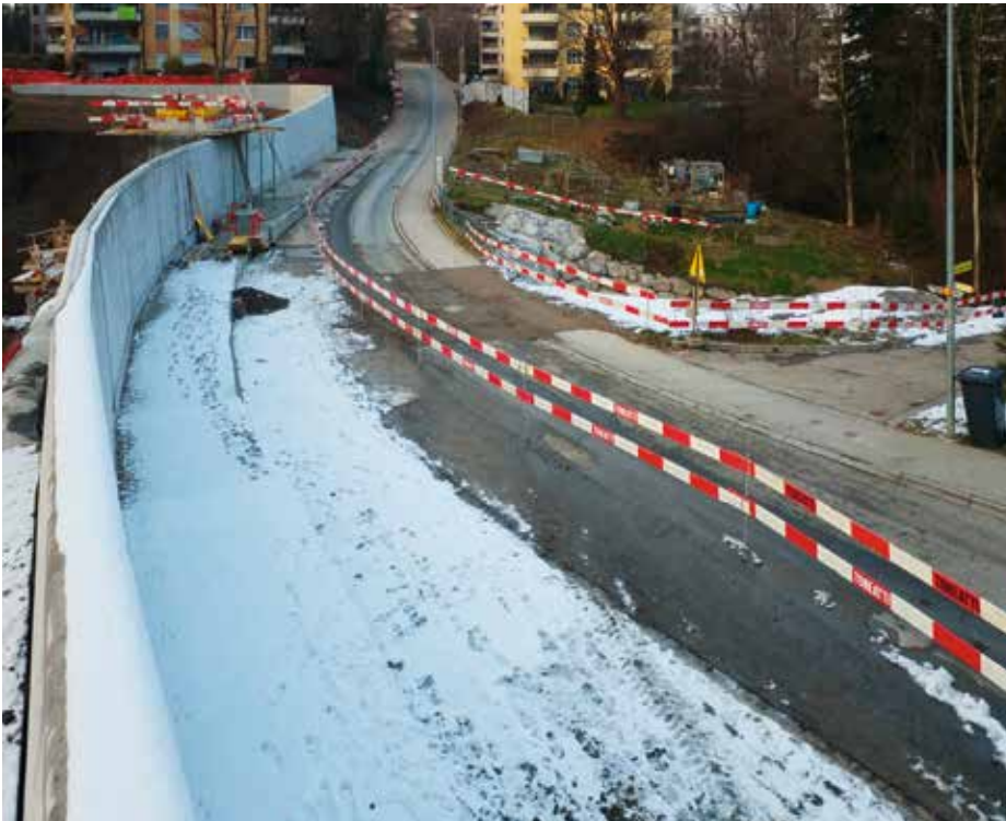
Hochwasserschutz Staldenbach: Rückhaltebecken Weid, Pfäffikon
