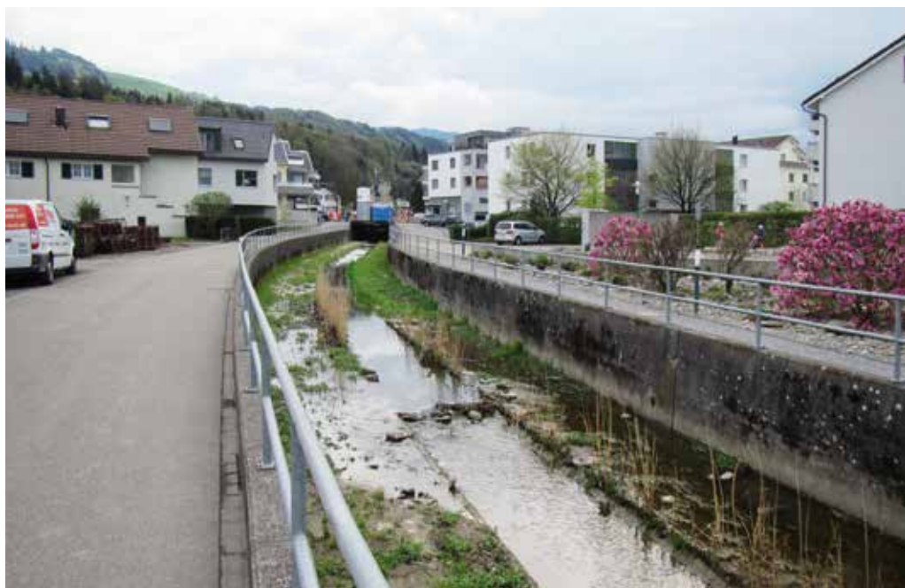
Canal Grande – Blick von SOB Bahnlinie Richtung Süden
