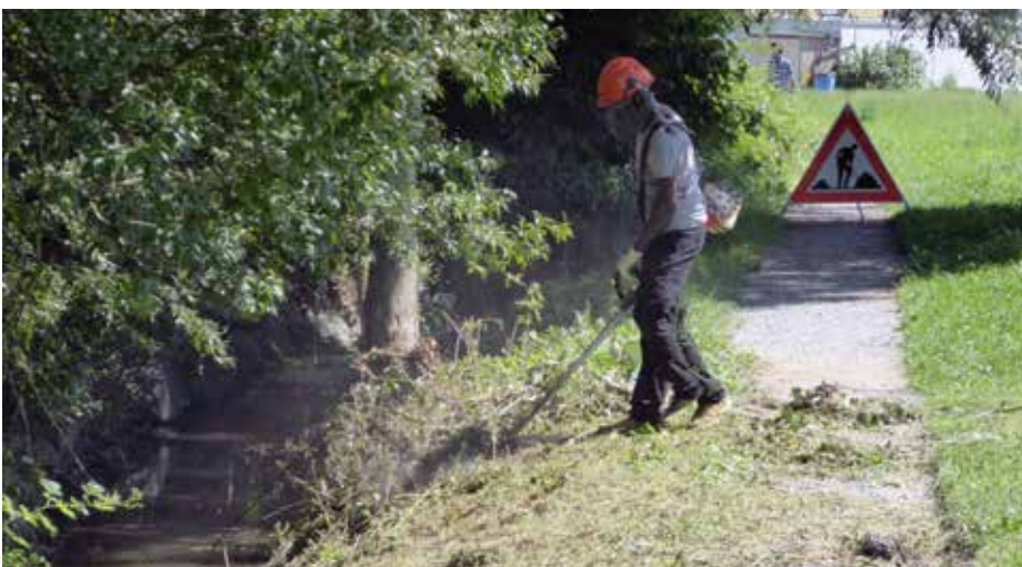
Unterhalt Sarenbach, Freienbach
