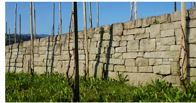
Im Rebberg Leutschen wurden zahlreiche Trockenmauern saniert
