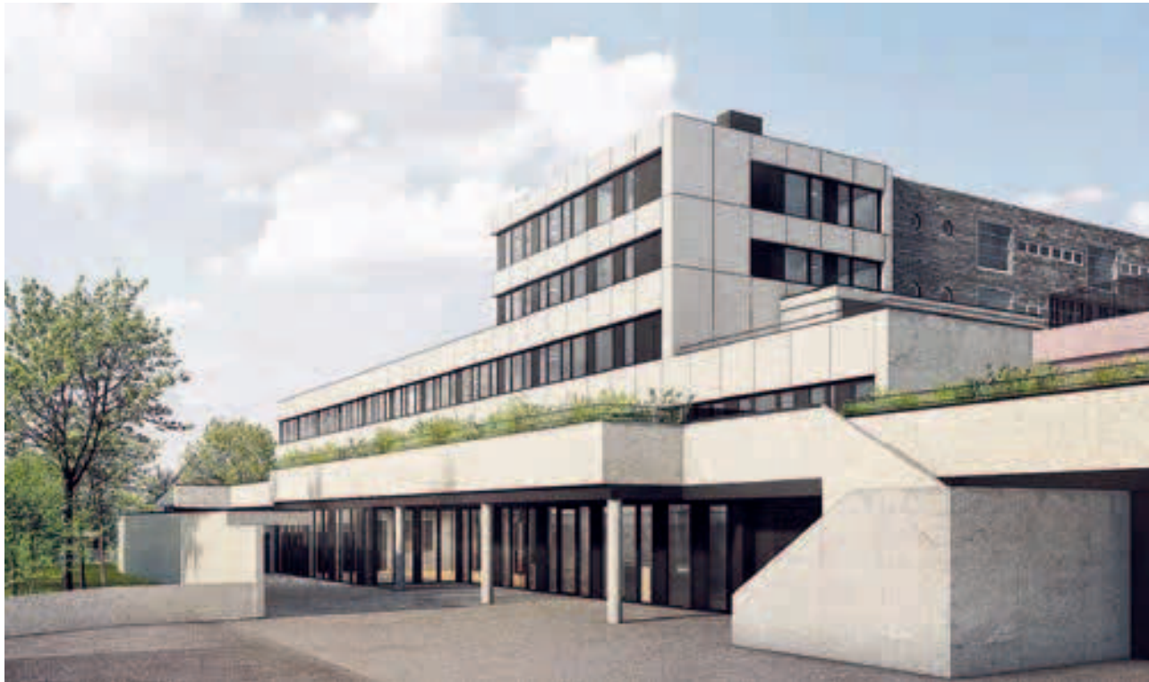
Die Mehrzweckhalle mit Kopfbau der Schule ist nur eines von vielen neuen Elementen in der Riedmatt Wollerau.
