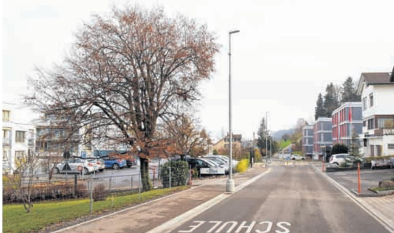
Die in regelmässigen Abständen in der überfahrbaren Rinne der Dorfstrasse Feusisberg eingebauten Beleuchtungskandelaber sollen die Sicherheit der Fussgänger erhöhen, sind allerdings eine Unfallgefahr für die Fahrzeuge.
