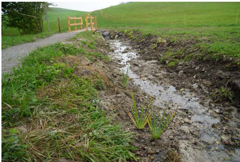
Das Pilgerwegbächli am Jakobsweg mit neu erstellter Holzbrücke
